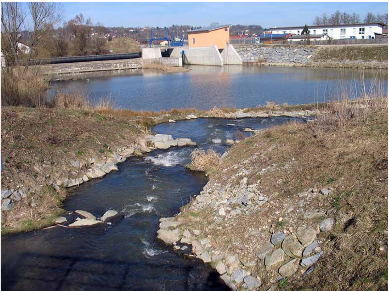
Bild oben und unten Fischtreppe
