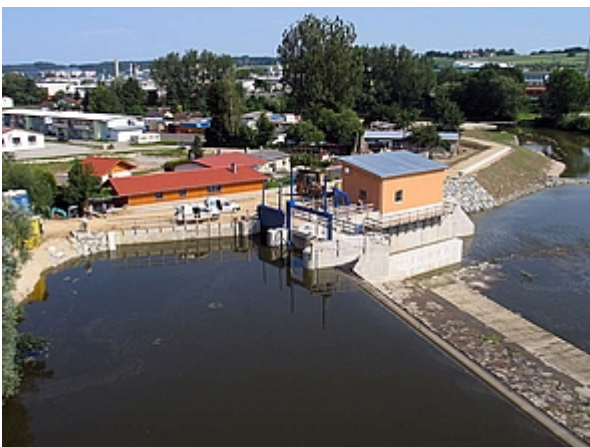
Oberwasser mit Wasserkraftanlage
