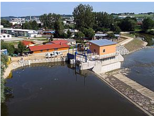
Oberwasser mit Wasserkraftanlage
