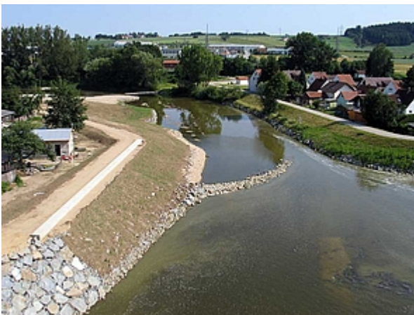
Unterwasser der Turbine mit Leitbuhne
